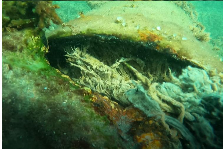
*Desconexión con acumulación de material de desecho taponando la conducción*
